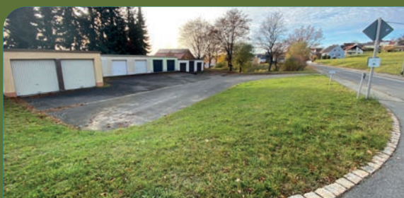
Zufahrt und Vorplatz beim „Brauweiher“ sollen umgestaltet werden um unkontrollierten Wassereintrag zu vermeiden.
