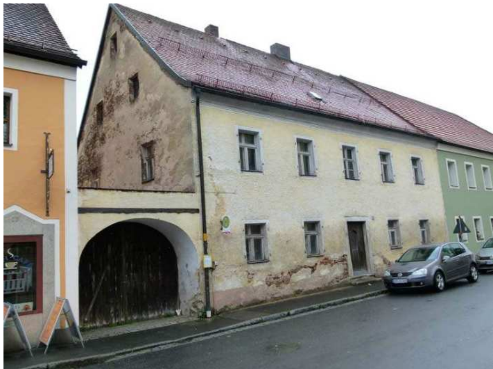
Ehem. Benefiziatenhaus, zweigeschossiger traufständiger Satteldachbau, mit korbbogiger Hofeinfahrt, Portal bez. 1826 (Denkmal).
