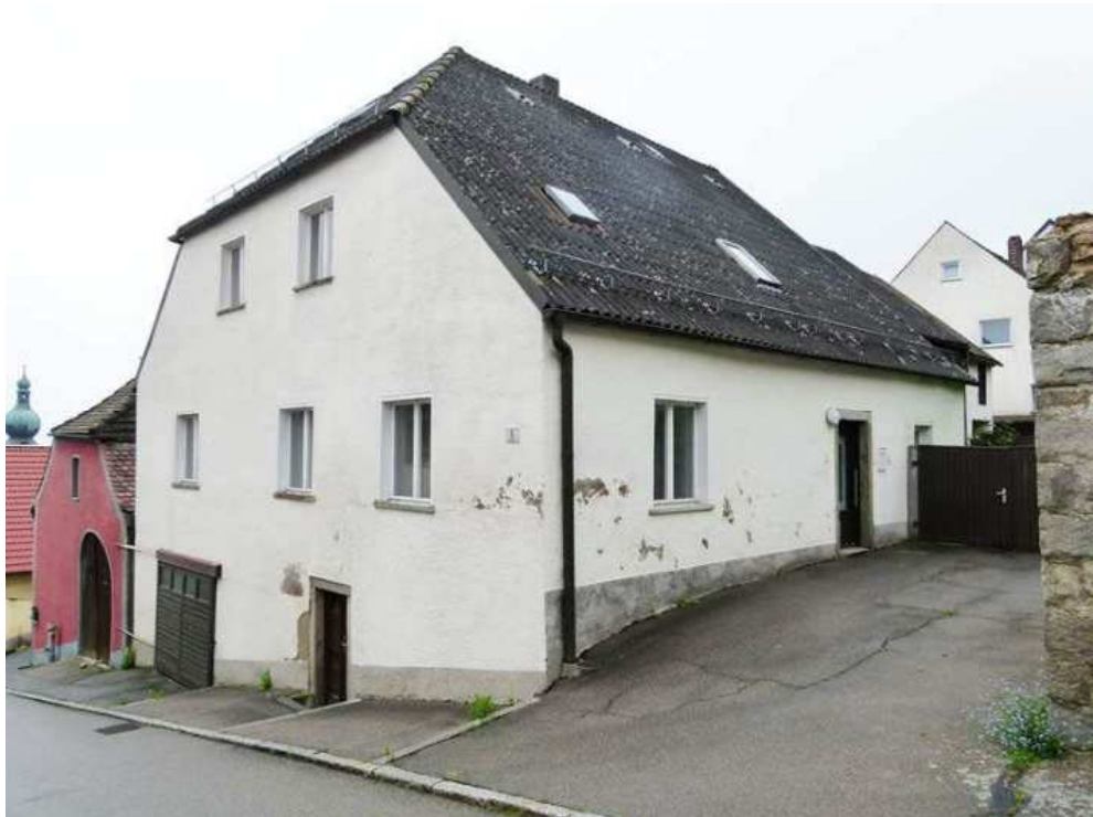
Erdgeschossiges Wohnhaus mit Halbwalmdach.
