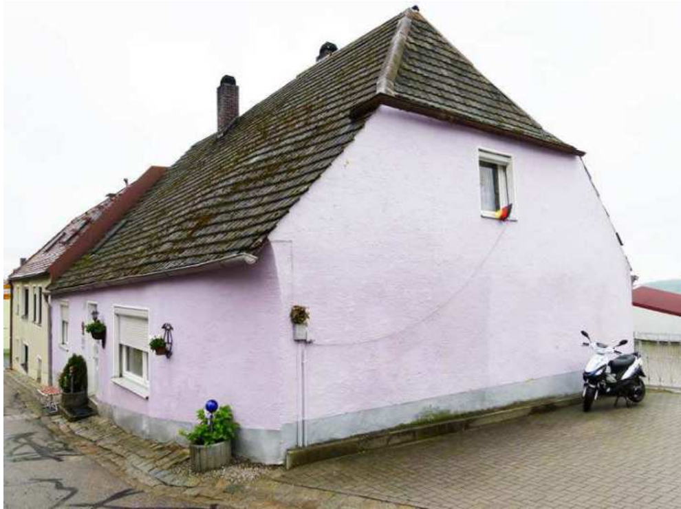
Erdgeschossiges Wohnhaus mit Halbwalmdach.
