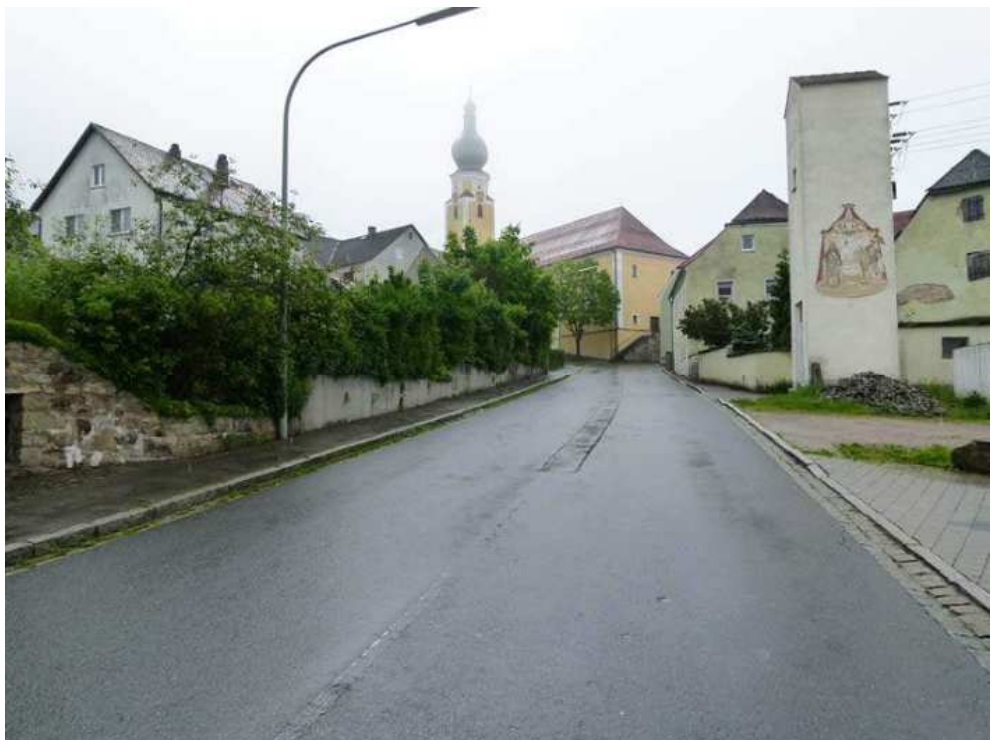
Großenschwandner Straße: Westlicher Eingang in den Altort.
