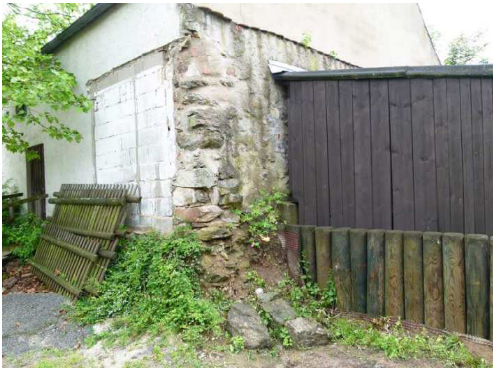
Rückwärtig am Scheunengebäude integriertes Bruchsteinmauerwerk, Rest der ehemaligen Marktbefestigung, wohl 1570 (Denkmal).
