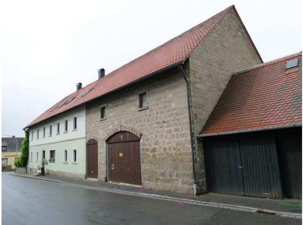
Stattlicher Bauernhof, zweigeschossiges Bauernhaus mit Steildach und angebautem Wirtschaftsteil mit Natursteinmauerwerk.
