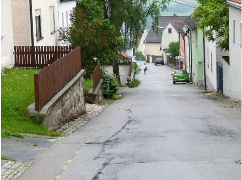
Straßenraum Hafnergasse mit geradliniger geplant wirkender Straßenachse.
