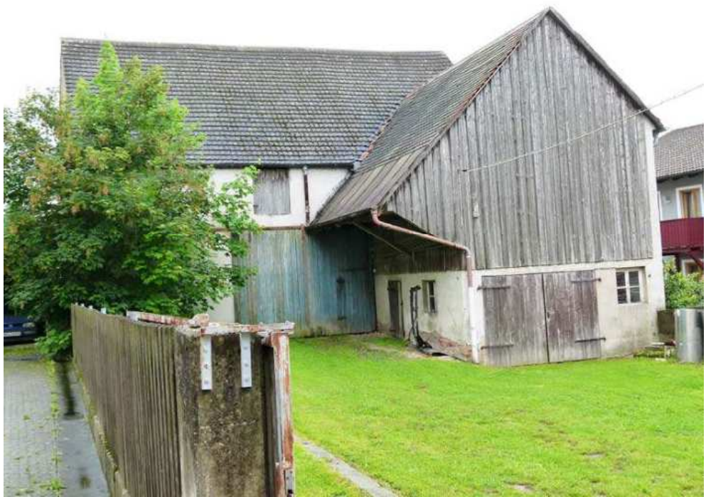
Zugehörige Satteldachscheune mit Anbau.
