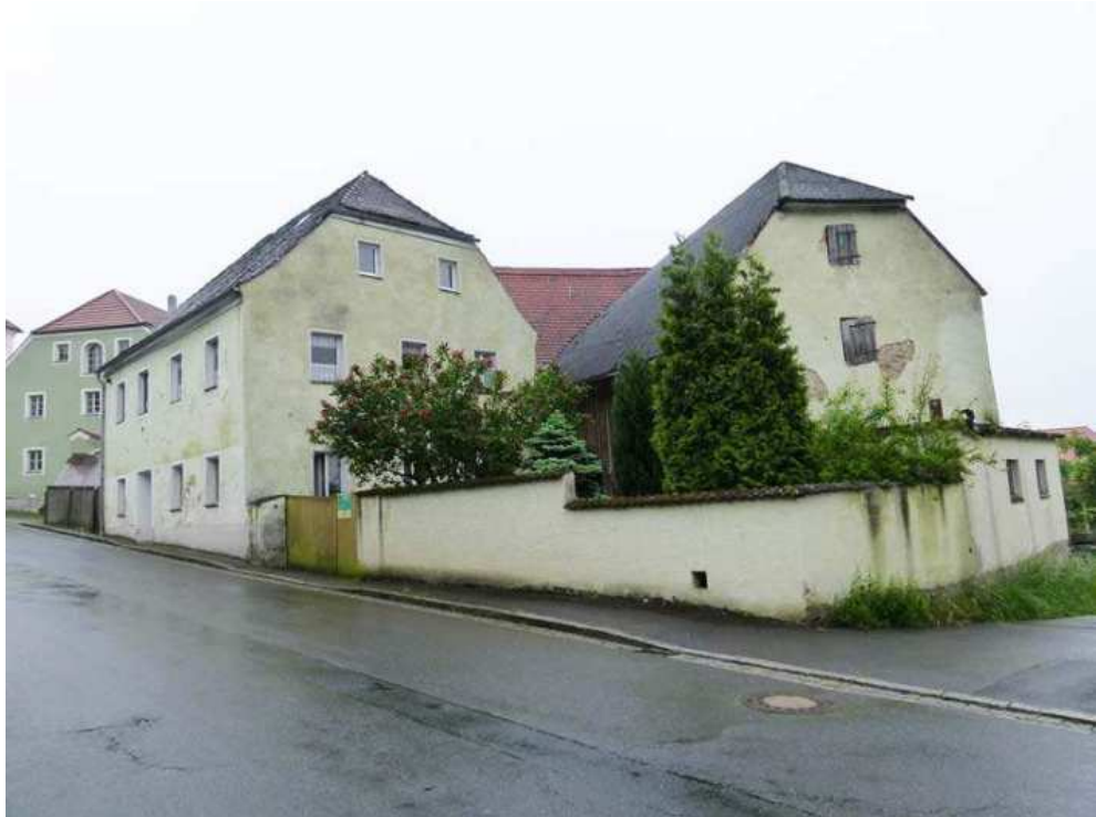
Zweigeschossiges Wohnhaus mit Halbwalmdach und zugehörigem Scheunengebäude.
