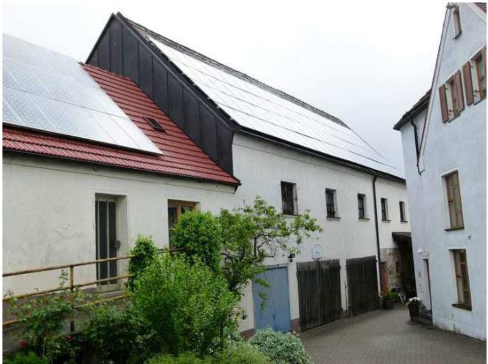
Hochaufragende langgestreckte Satteldachscheune.
