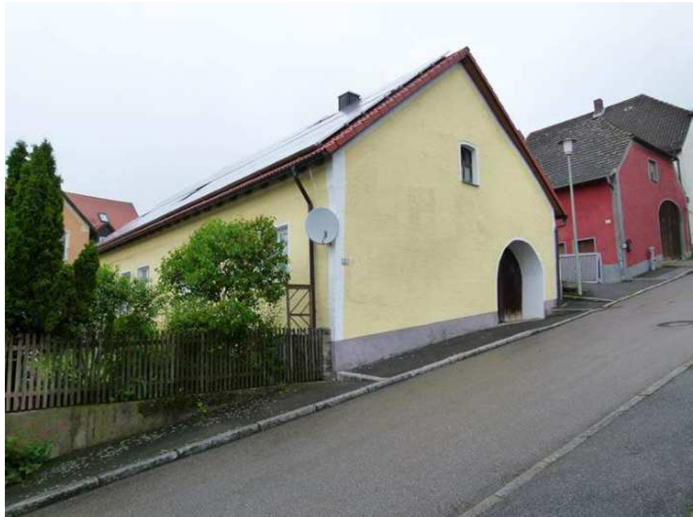
Erdgeschossiges langgestrecktes Wohnhaus.
