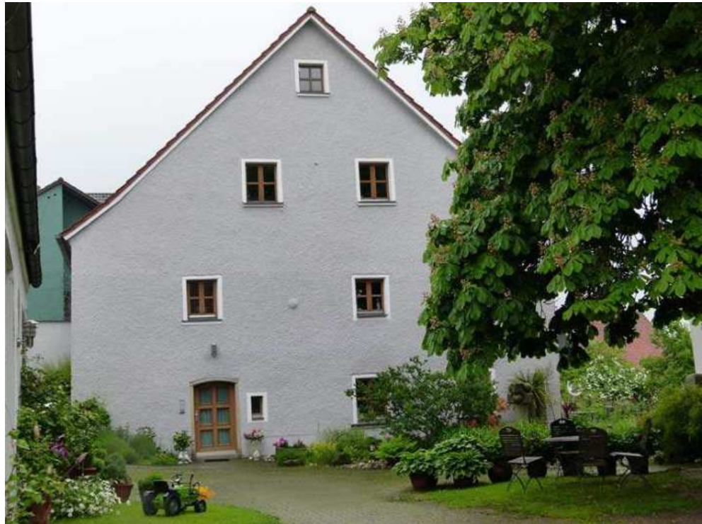
Ehem. Gasthaus, zweigeschossiger traufständiger Satteldachbau, bez. 1798, im Kern älter, Tiefbrunnenschacht wohl 18. Jh. (Denkmal).
