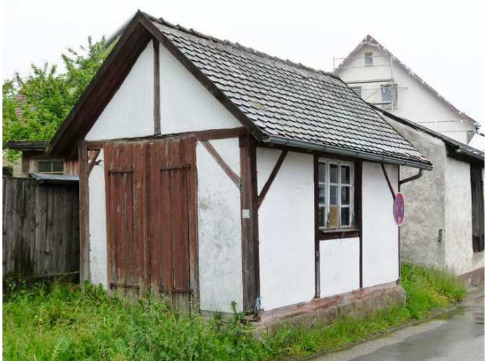
Kleingebäude, wohl ehemaliges Waaghaus.
