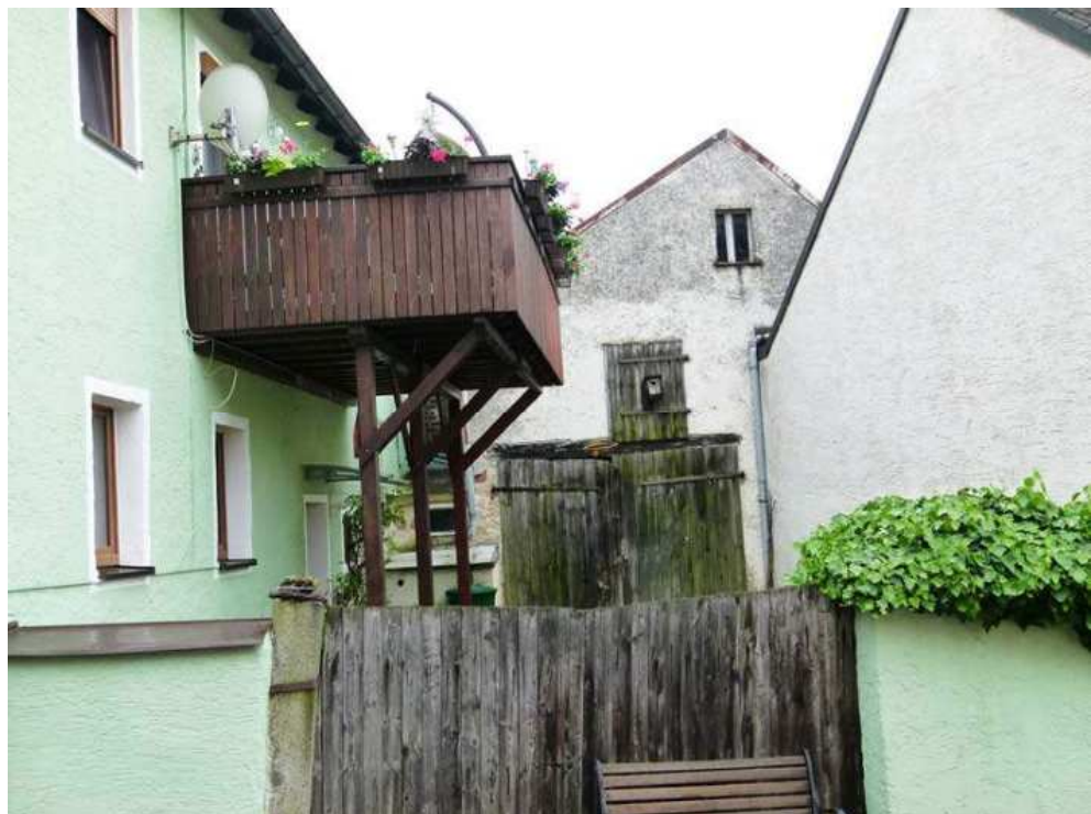
Ehemaliges landwirtschaftliches Nebengebäude.
