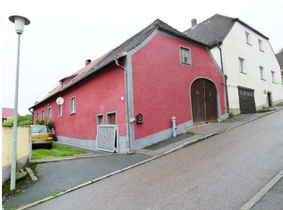
Erdgeschossiges Wohnhaus mit Halbwalmdach und Tor zum ehemaligen Wirtschaftsteil.
