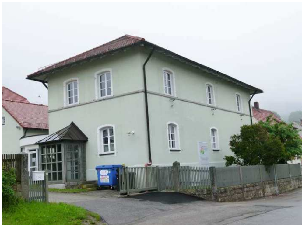
Ehemaliges Forsthaus, stattlicher zweigeschossiger Walmdachbau.
