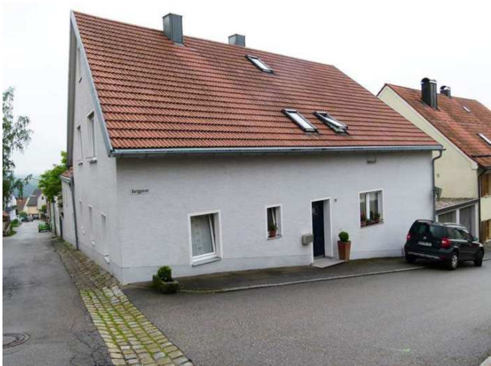
Gebäude mit gemauertem Hauskeller, wohl 18.Jh. und Felsenkeller wohl 2. Hälfte 19. Jh. (Denkmal).
