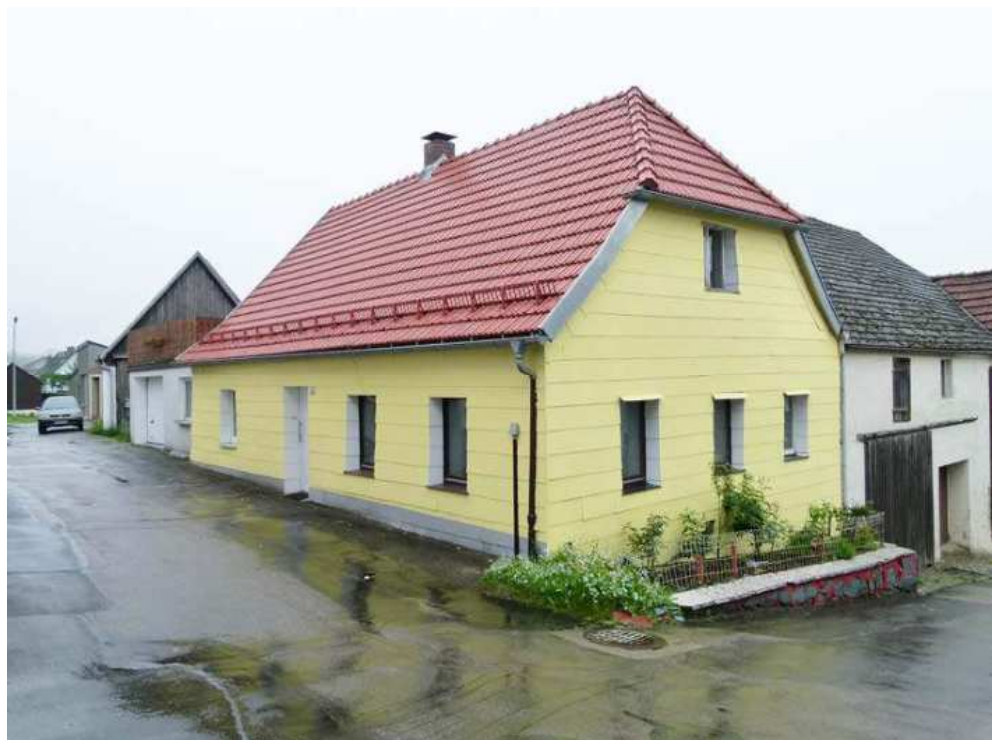
Erdgeschossiges Wohnhaus mit Halbwalmdach.
