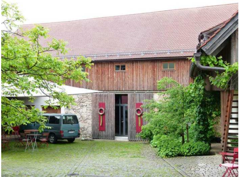
Nebengebäude, langgestreckte Satteldachscheune mit winkelförmig angebautem erdgeschossigem Satteldachbau, im Kern frühes 19. Jh. (Denkmal).
