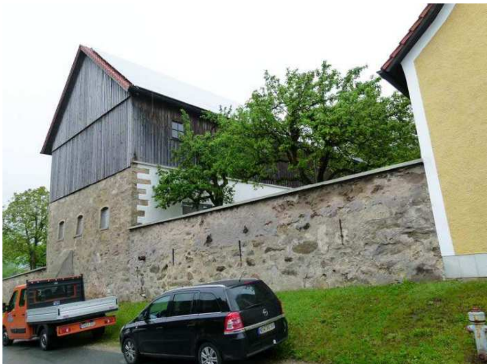
Stattliches hochaufragendes Scheunengebäude mit zugehöriger Stützmauer.
