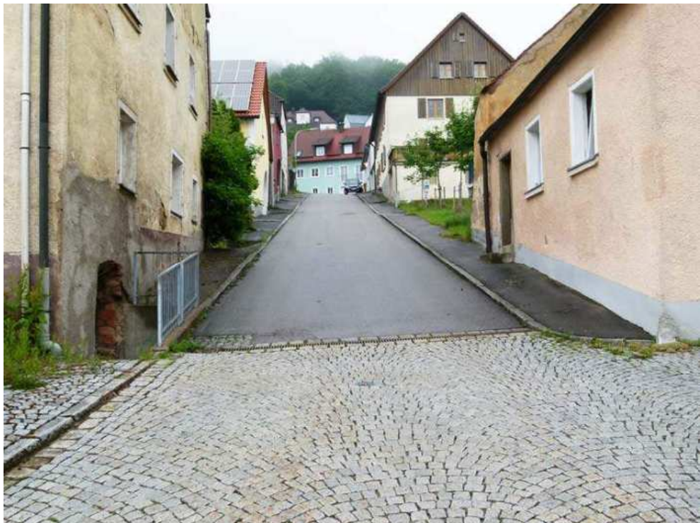
Straßenraum Berggasse mit geradliniger geplant wirkender Straßenachse.
