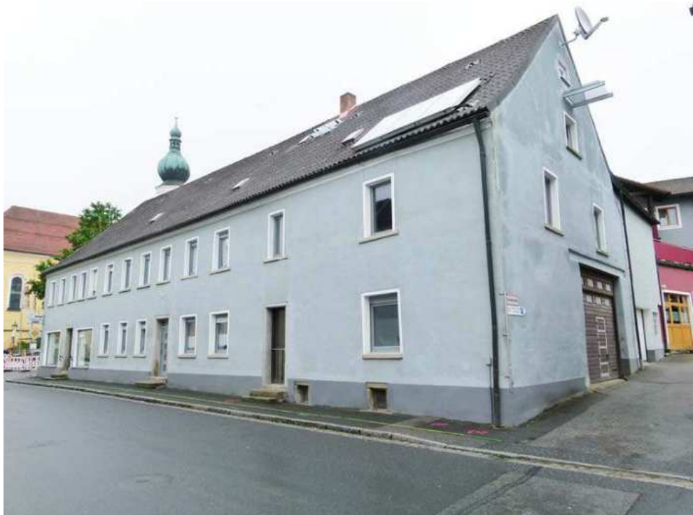
Langgestreckter zweigeschossiger Traufseitbau.
